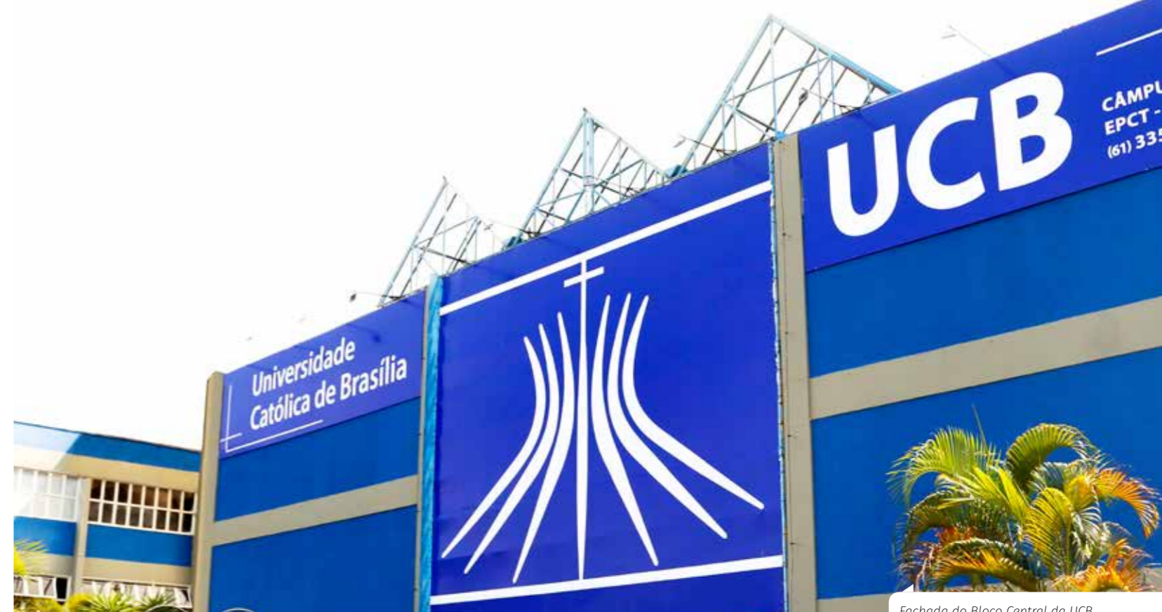
Fachada do Bloco Central da UCB
